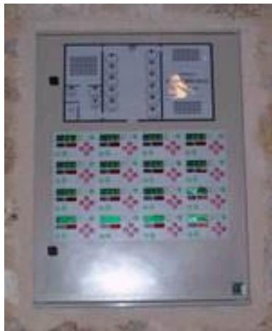
Les régulateurs de température sont des appareils électroniques industriels capables de convertir les températures mesurées par les sondes (Pt100, Pt1000 ou autres PTC et Thermocouples) et d'actionner des vannes automatiques ou d'autres appareils par l'intermédiaire de sorties relais.
